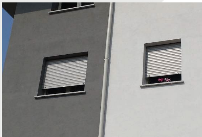
Particolare tapparella motorizzata in alluminio
