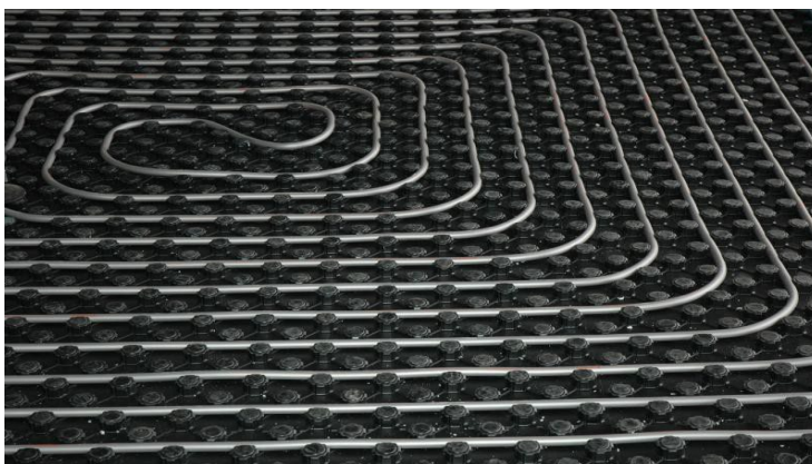
Riscaldamento a pavimento
